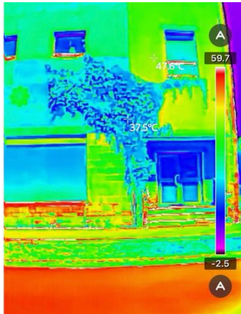
~10°C (max.) Kühlung durch punktuell Fassadengrün
