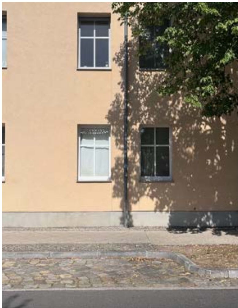
Dahmer Straße, 13.08.2025, ca. 15:10 32°C Lufttemperatur, 29% Luftfeuchte
