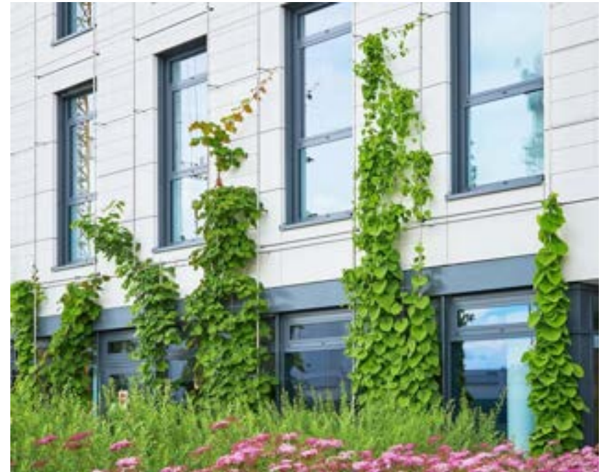
Grüne Fassade Neckarpark, Stuttgart
