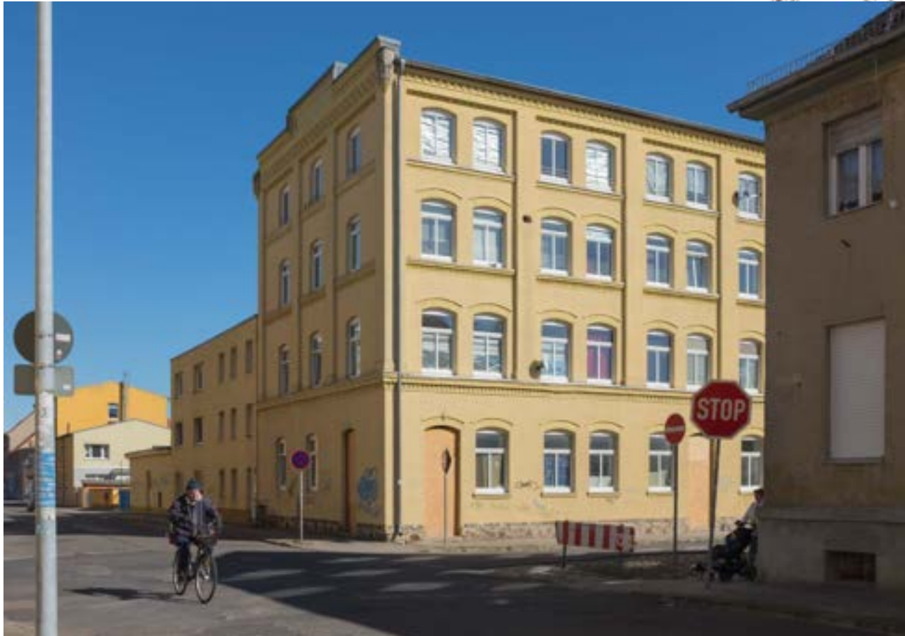
Bild 6521, Ecke Puschkinstraße/Grabenstraße 4-geschossiges Wohngebäude, Eckgebäude, nicht-öffentlich
