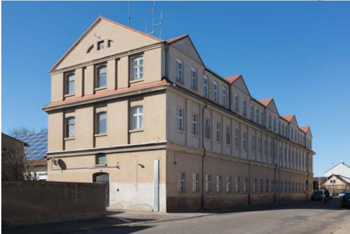
Bild 6537, Grabenstraße 3-geschossiges Verwaltungsgebäude, straßenbündig, öffentlich (Lehrrettungswache)
