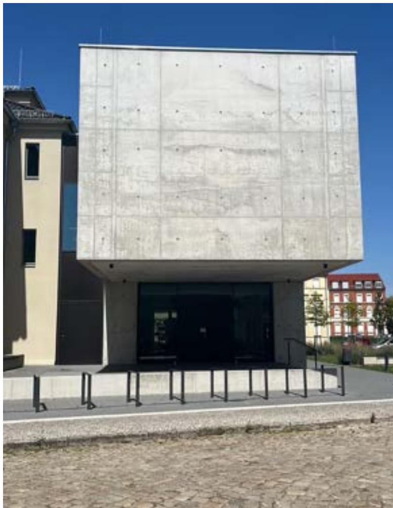
Auguststraße, 13.08.2025, ca. 14:30 31°C Lufttemperatur, 29% Luftfeuchte
