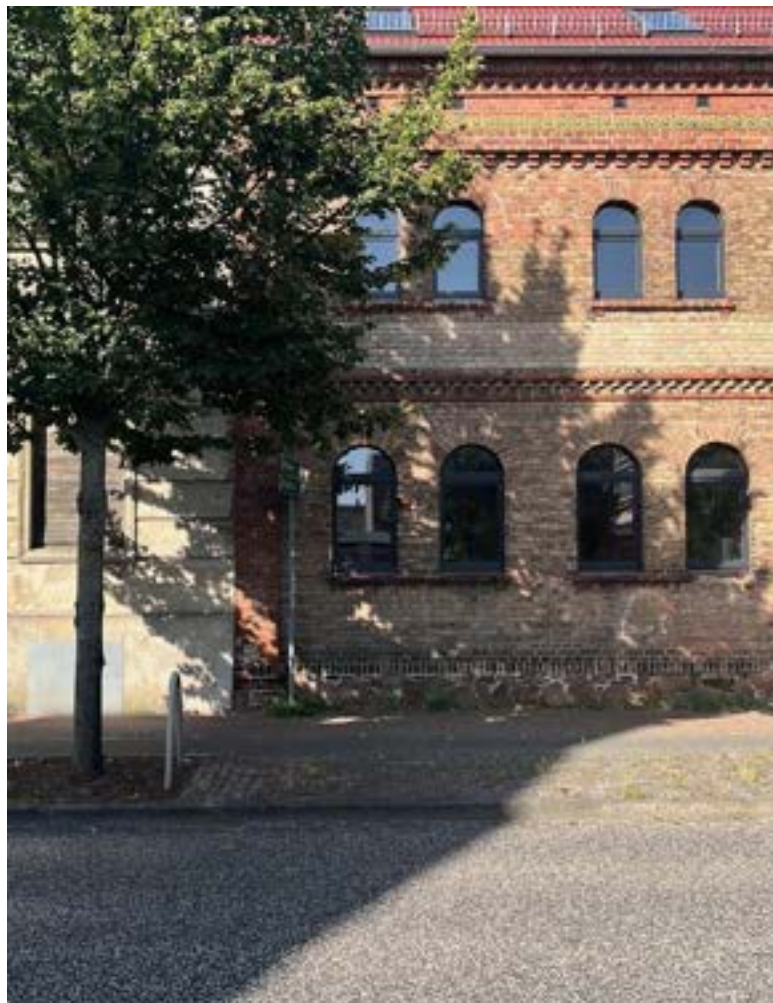
Beelitzer Straße, 13.08.2025, ca. 17:00 31°C Lufttemperatur, 29% Luftfeuchte
