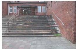
Abb 4. Bereits erfolgter teilweiser Rückbau der Treppe
