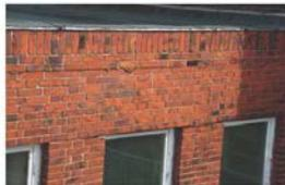
Abb 3. Risse durch statische Auflastungen oder Verschleißspuren
