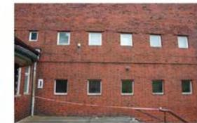
Abb 2. Horizontalfuge im Bereich der Fensterstürze
