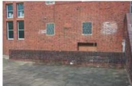
Abb 1 Verfärbungen im Klinkermauerwerk durch schadhafte Fugen
