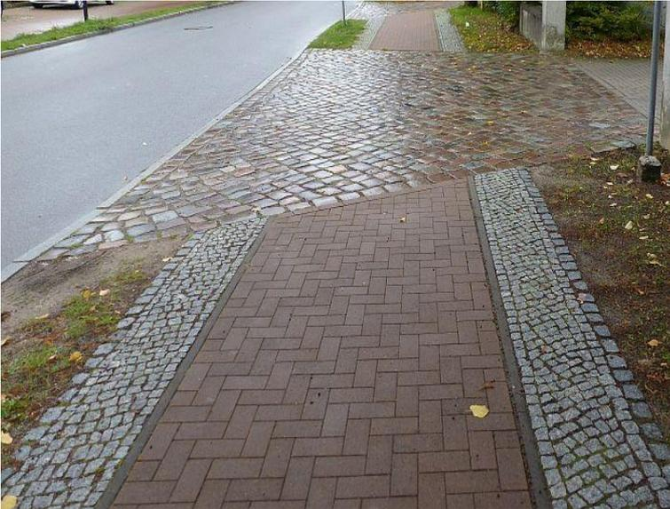
So sieht es dann sehr häufig aus: Die gesamte Gehwegfläche ist zum Fahrstreifen hin abgesenkt, es ist ein gröberes Pflaster eingebaut, der Pflasterwechsel ist schräg zur Gehrichtung und bei feuchter Witterung oder gar bei Glätteis ist dies eine Situation zur Förderung von sogenannten „Eigenunfällen“. Bevorzugt Oberschenkelhalsbrüche, die bei älteren Menschen häufig das Lebensende bedeuten.
