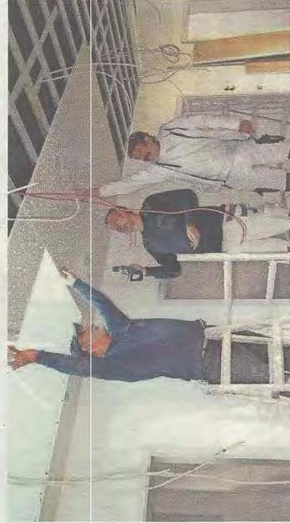
Zurzeit ist im Neubau der Innenausbau im Gange. Die Trockenbauer bringen die Akustikdecken an. FOTO: ELINOR WENKE
