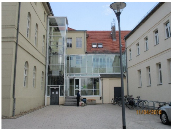
Hinterhof Rathaus – Aufzug
