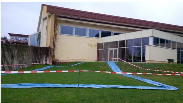
Der Einbau der Wassertechnik für das Außenbecken wird, mangels Platzkapazitäten im Technik Keller, im Außenbereich erfolgen müssen. Dazu ist der Neubau eines kleinen Technikgebäudes erforderlich. Statt der bisher eingebauten Technik empfiehlt sich hier die Verwendung von Filteranlagen, die eine deutlich geringere Höhe benötigen. Dadurch lassen sich diese Filter leichter in die abfallende Geländeform integrieren.
