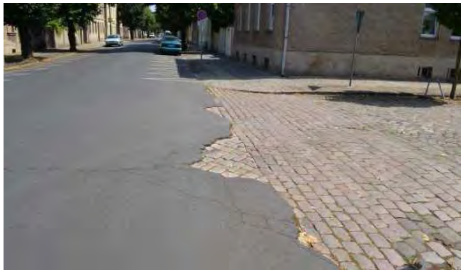
Abb. 27: Straßenbelag in der Dahmer Straße
