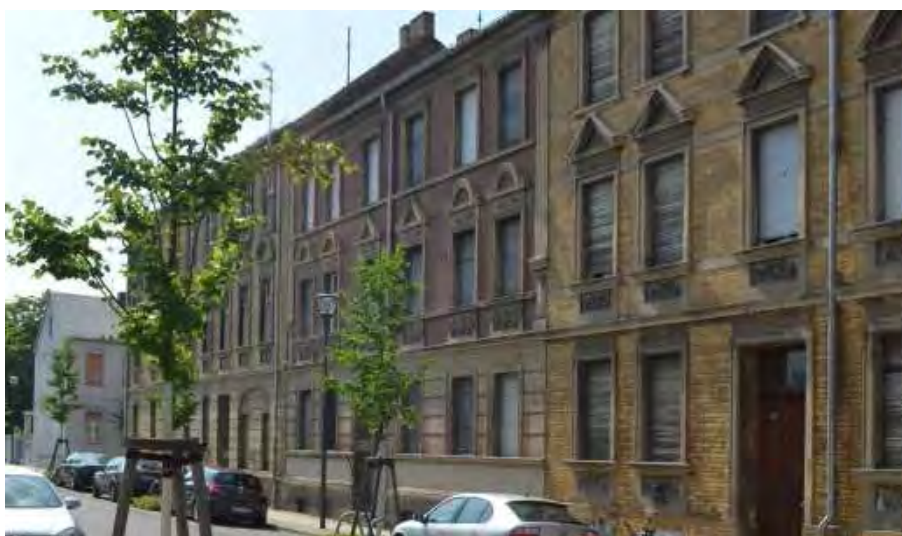
Abb. 17: Unsanierete Blockrandbebauung in der Grünstraße
