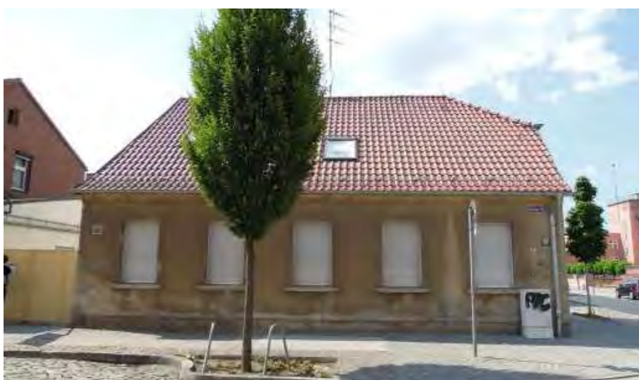
Abb. 18: Teilsaniertes „Ackerbürgerhaus“ in der Grünstraße
