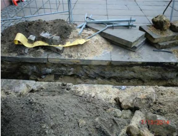
Die Bestandsplatten wurden hinsichtlich Ihrer Materialität und Haltbarkeit von einem Labor beprobt, zusätzlich wurden im Rahmen von Suchschachtungen die Art der Verlegung untersucht.
